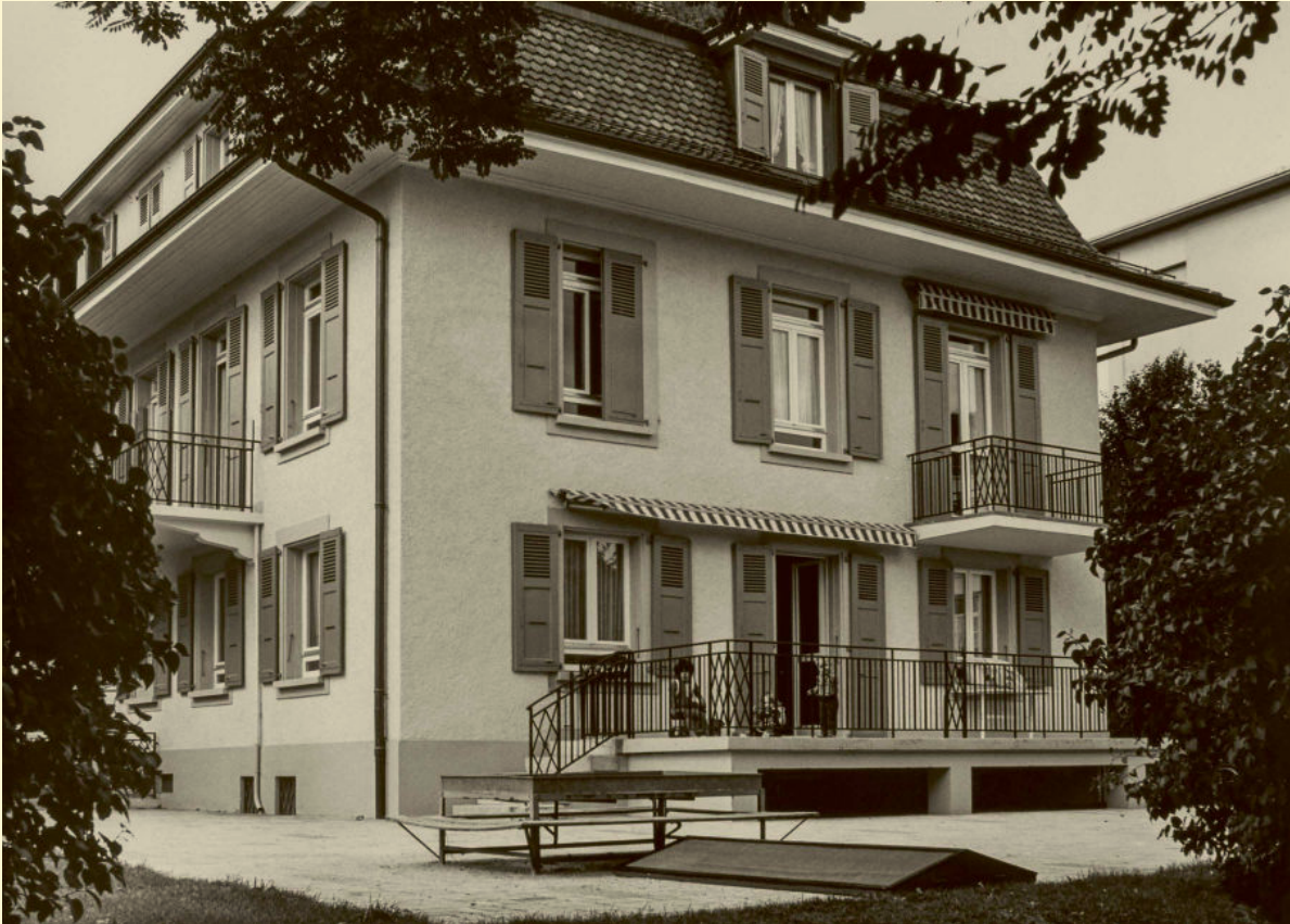
→ Le bâtiment de Beaumont a vécu de nombreuses adaptations et rénovations.
